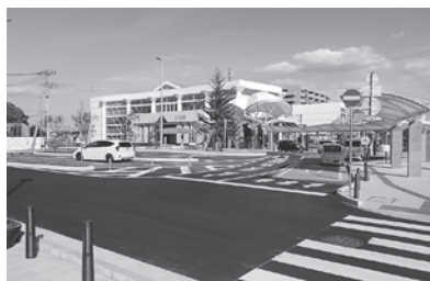
現在の東海駅西口広場
