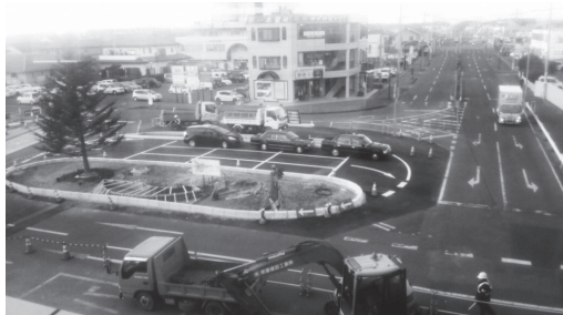
整備が進む東海駅西口
