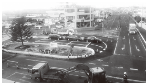
整備が進む東海駅西口
