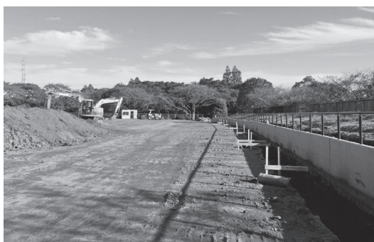
改修中の阿漕ヶ浦ホッケー場
