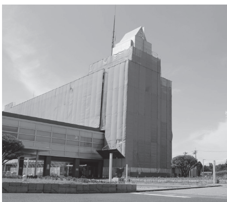
外装改修中の庁舎
