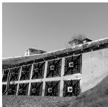
南台団地の滑動崩落対策箇所
