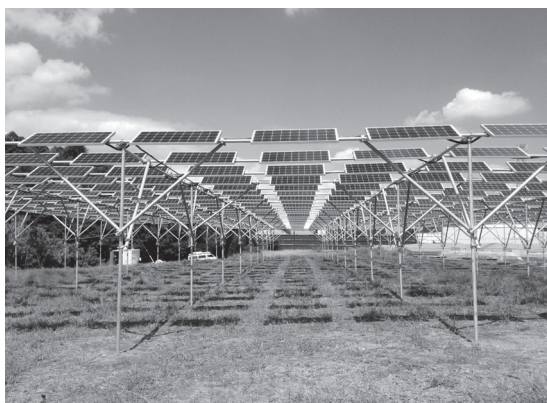
ソーラーシェアリング設備 (ソーラーシェアリング協会HPより転載)
