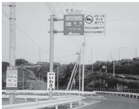
東海スマートIC下りの入口と出口
