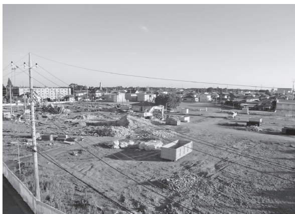
解体中の三菱原燃の社員住宅
