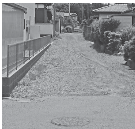
現道舗装予定地
