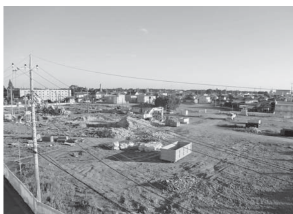
解体中の三菱原燃の社員住宅
