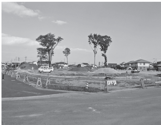
舟石川近隣公園の現況（平成27年3月完成予定）
