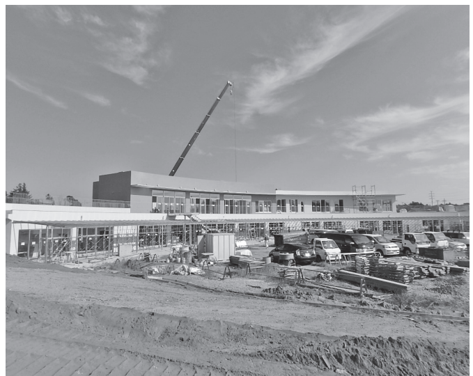
建設中の幼保連携施設
