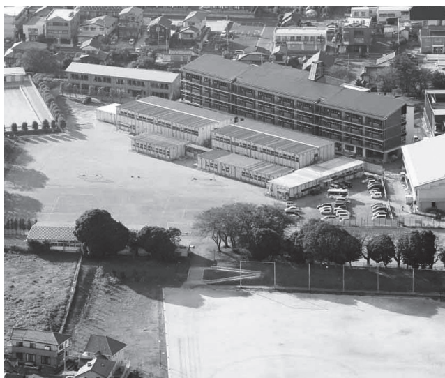
建設中の東海中学校
