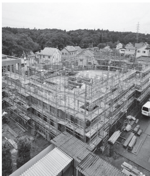
建設中の中丸小学校
