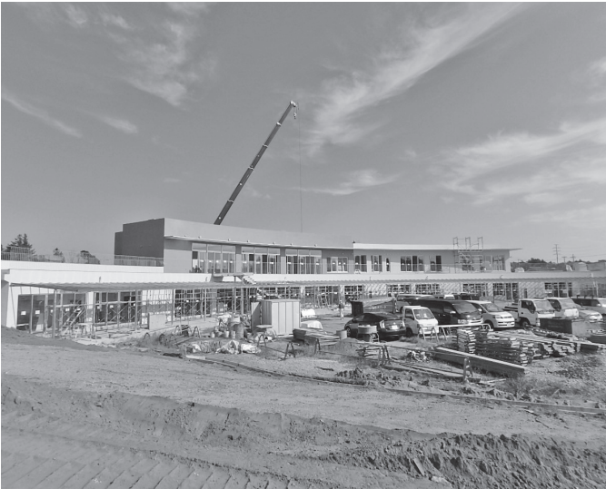
建設中の幼保連携施設
