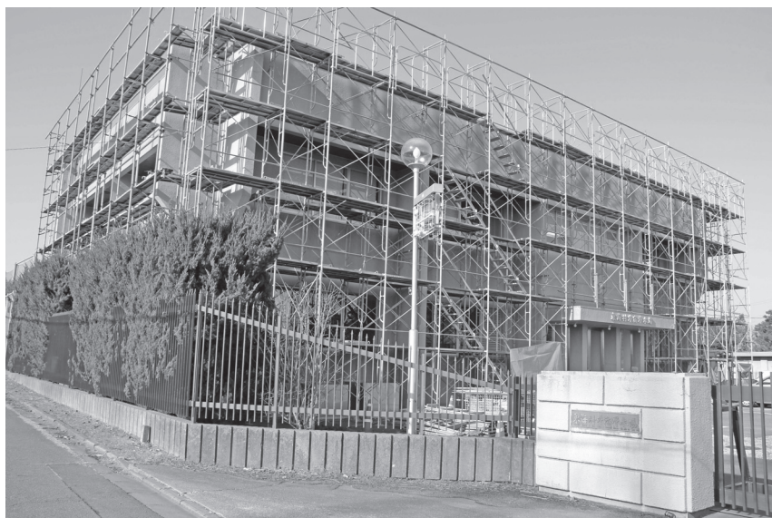
外宿浄水場・耐震補強工事
