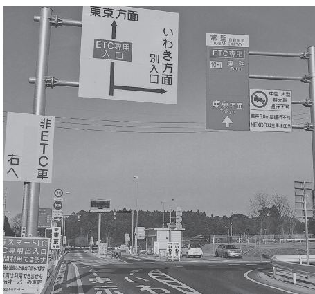
東海スマートIC出入口
