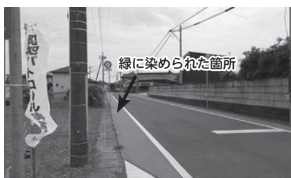
歩行空間確保のためのグリーンベルトが施された村道
