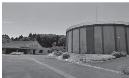
県水を受け入れる須和間配水場
