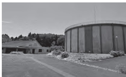
県水を受け入れる須和間配水場
