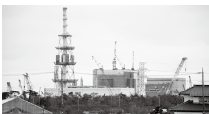
再稼働に向けて、新規制基準対応の工事を進める東海第二発電所
