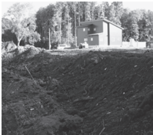
盛土事業中の現場
