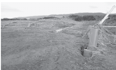
破損したソフトボール場バックネット
