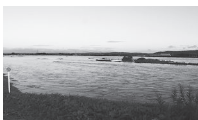
石神外宿地内堤防から榊橋を望む
