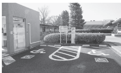
利用者に配慮した屋根付きの優先駐車場の整備が必要
