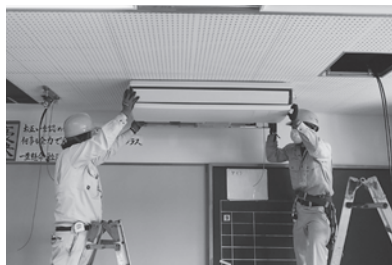
東海中学校エアコン設置の様子
