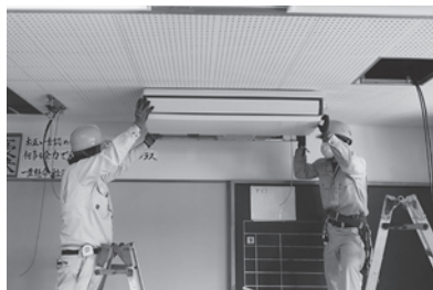
東海中学校エアコン設置の様子
