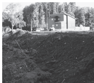
盛土事業中の現場
