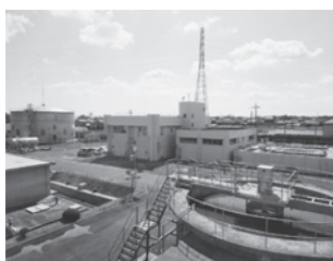
建設から42年経過し、老朽化した外宿浄水場
