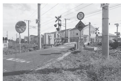
早期改善が望まれる白方街道踏切
