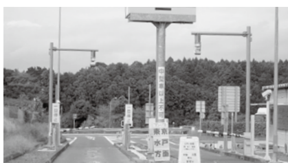
中型車以上不可の表示のある 東海スマートインターチェンジ入口
