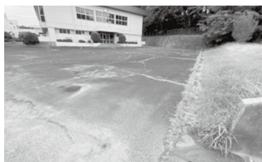
保護者駐車場に予定されている体育館脇のスペース
