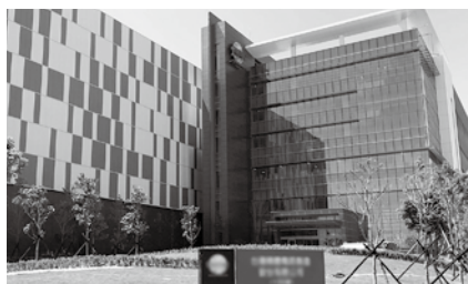
台湾の半導体製造会社の工場
