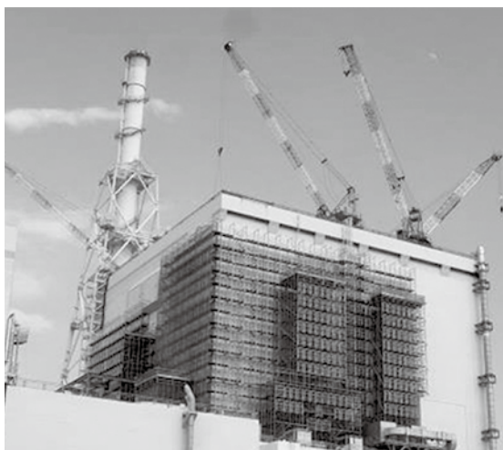
安全対策工事が進む東海第二発電所
