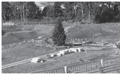
公園のシンボルツリー付近に、大型滑り台を設置
