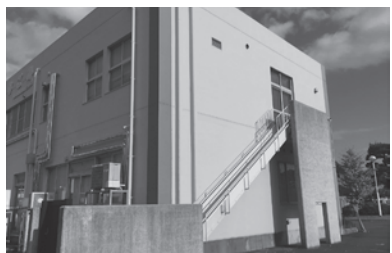
避難滑り台が設置されている「なごみ」施設
