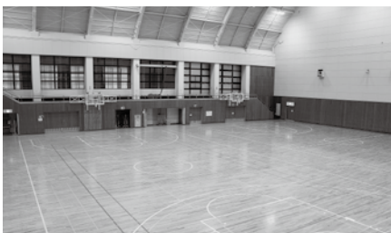
体育館に空調設備を
