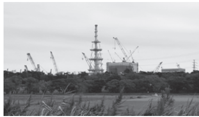
工事が進む東海第二原発 工事終了は2024年9月予定
