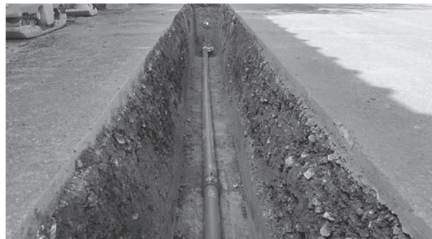
水道管布設工事中
