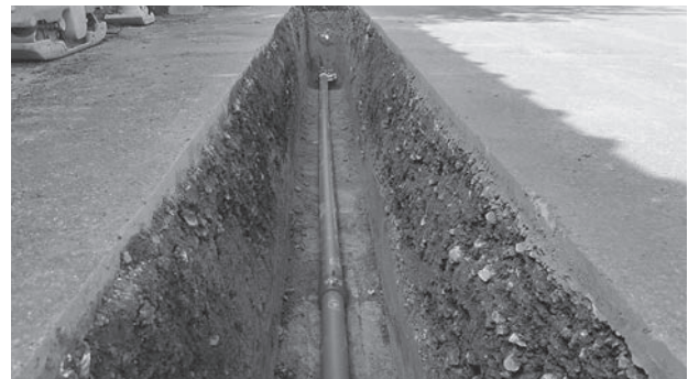
水道管布設工事中
