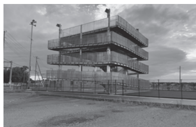
日立市神田町に完成した洪水避難タワー
