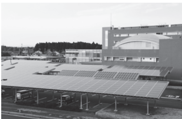
村は再エネなどの取り組みを加速させる(役場駐車場の太陽光発電)
