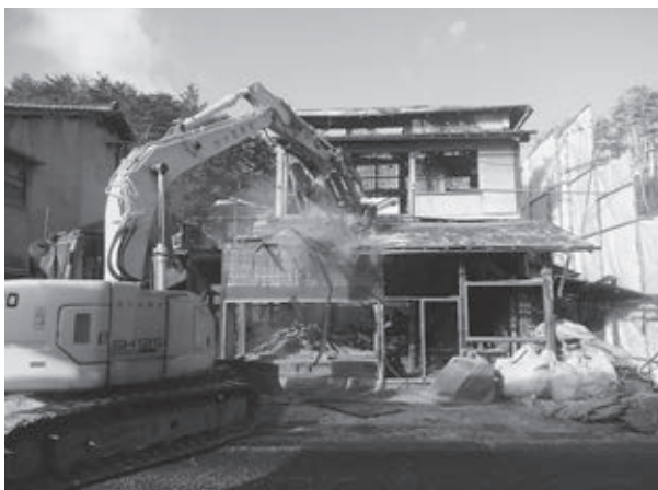
空き家解体の様子
