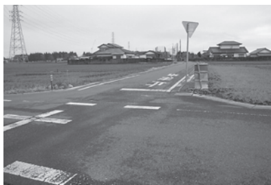
避難道路である外宿地内村道
