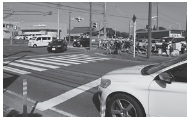
防護柵の設置が望まれる舟石川小学校入口交差点
