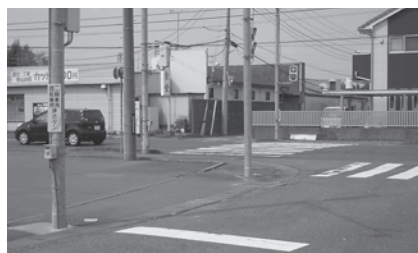
事業化が進む国道6号への取り付け道路
