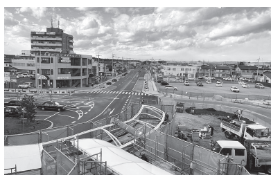
再整備が進む駅西口広場
