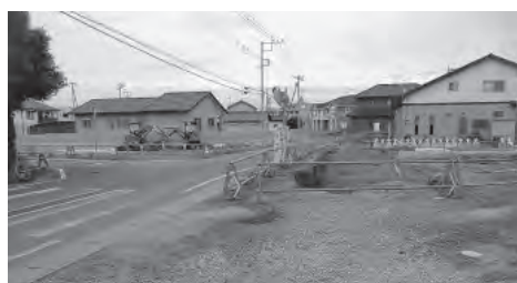
村外業者が受注した工事現場
