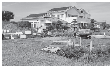
避難先のひとつ 白方コミセン (駐車場の工事中)
