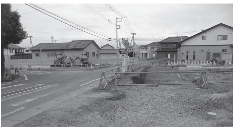
村外業者が受注した工事現場
