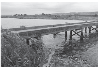
津波対策は防潮堤のみならず村内の橋も重要
