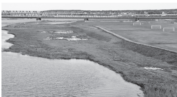
留大橋から望む亀下地区
