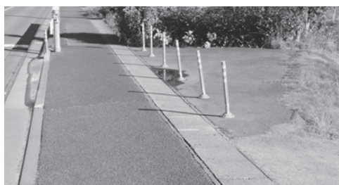
ガードレールによる安全対策を求める
