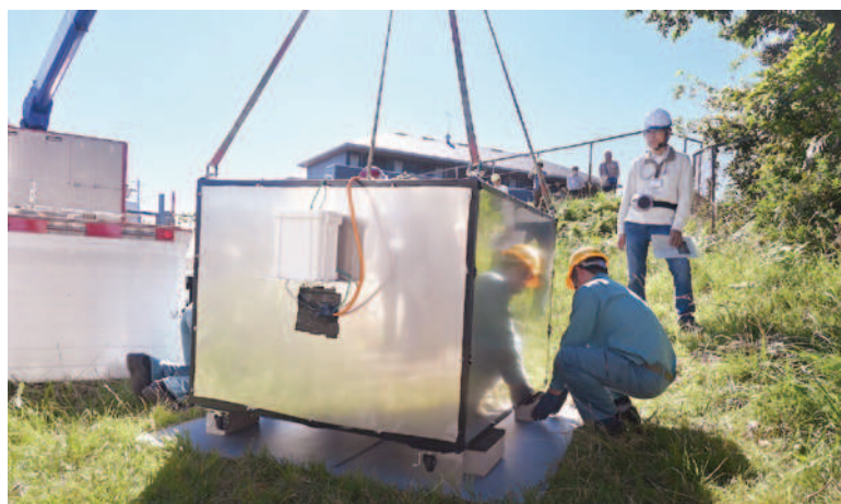
図3 測定器の設置作業
