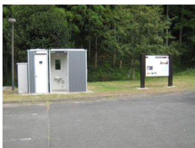
トイレ・説明板（北側駐車場）
