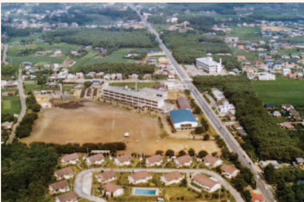
東海中学校と石橋向住宅(昭和60年代か)
